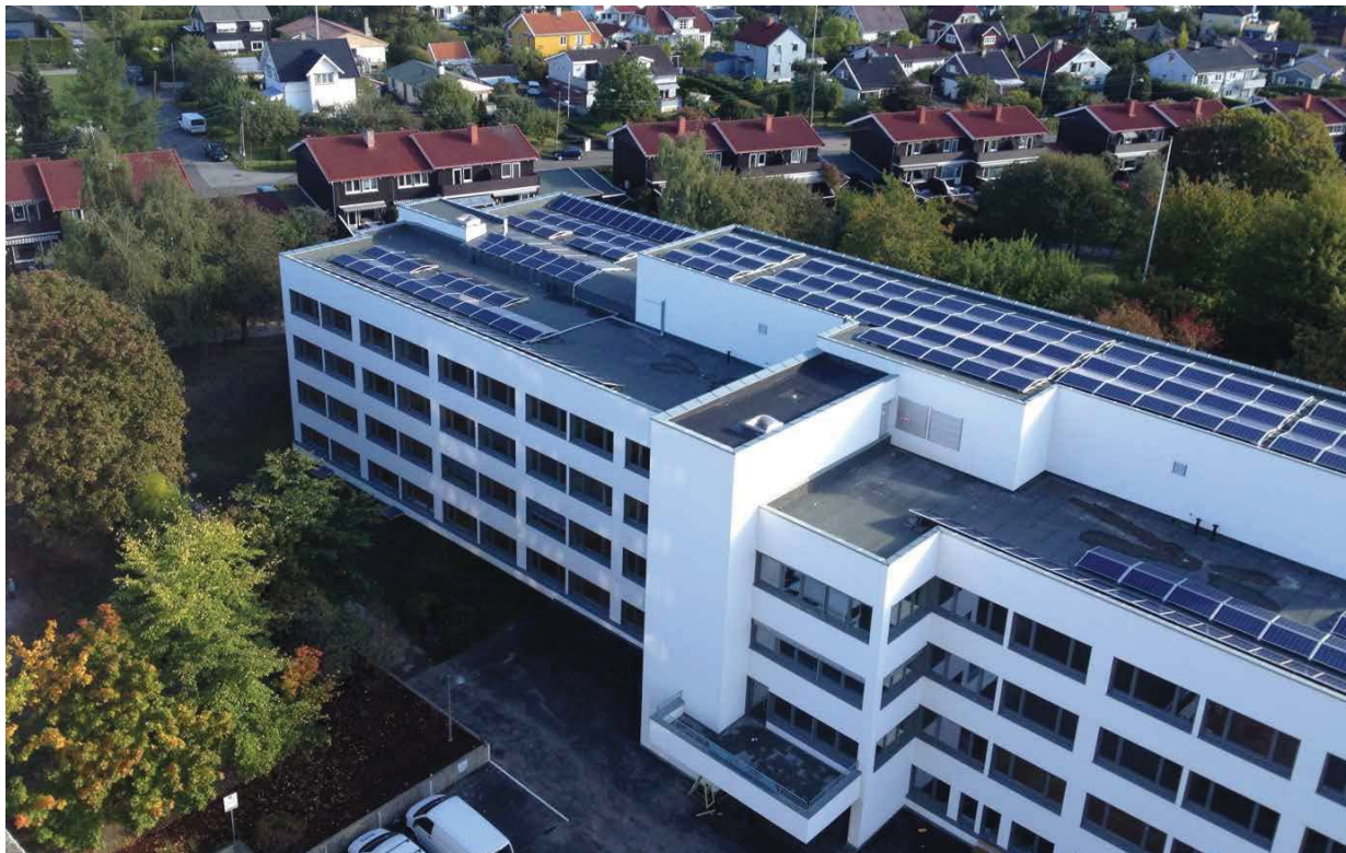
Økern sykehjem er blitt rehabilitert med mål om å kutte energibruken i bygget med nærmere 70 prosent. I tillegg skal minst 10 prosent av energiforbruket dekkes av produksjon fra solcellepaneler. Økern sykehjem er et eksempel på et Future Built-prosjekt. Foto: Tove Lauluten
